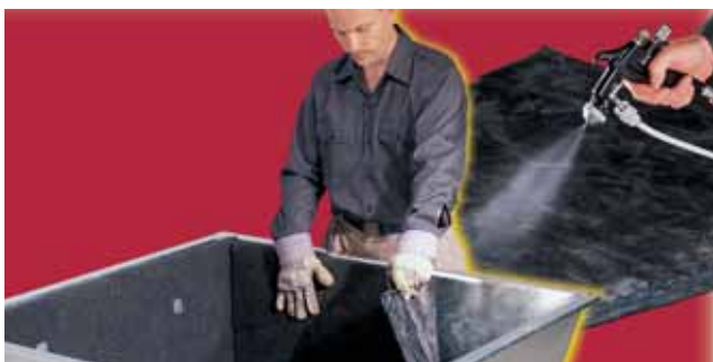
Lepení izolace v klimatizačním zařízení. Vhodné také k izolaci ve vytápěcích, ventilačních zařízeních a pro izolaci potrubí.
